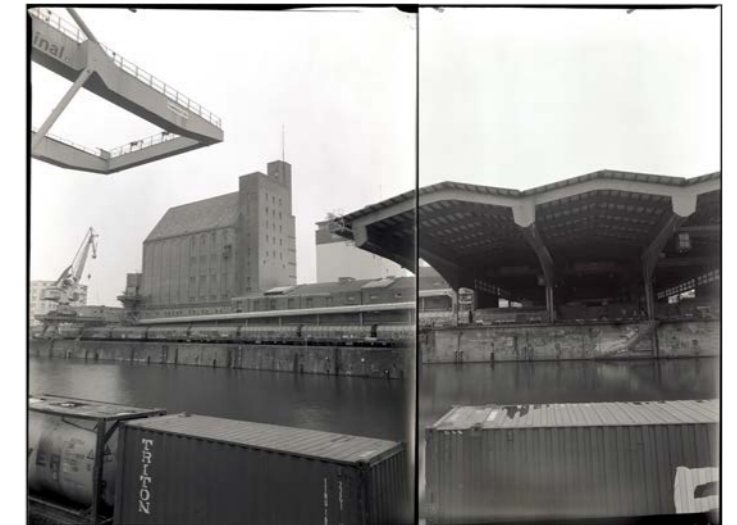
Getreidespeicher und Lagerhaus, Basel, 1923–1926 (Foto: E. Wolańska, 2014)
